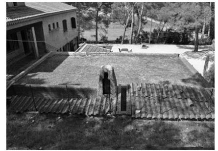
Flachdach der «Bergerie»
